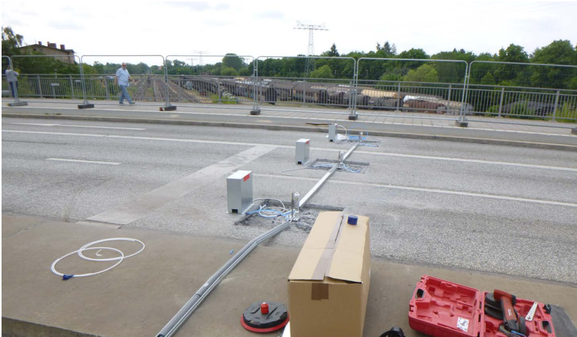
Abb. 7: Brücke des 20. Jahrestages am Altstädter Bahnhof – Installation der Messanlagen im Juni 2020, Foto: LS
