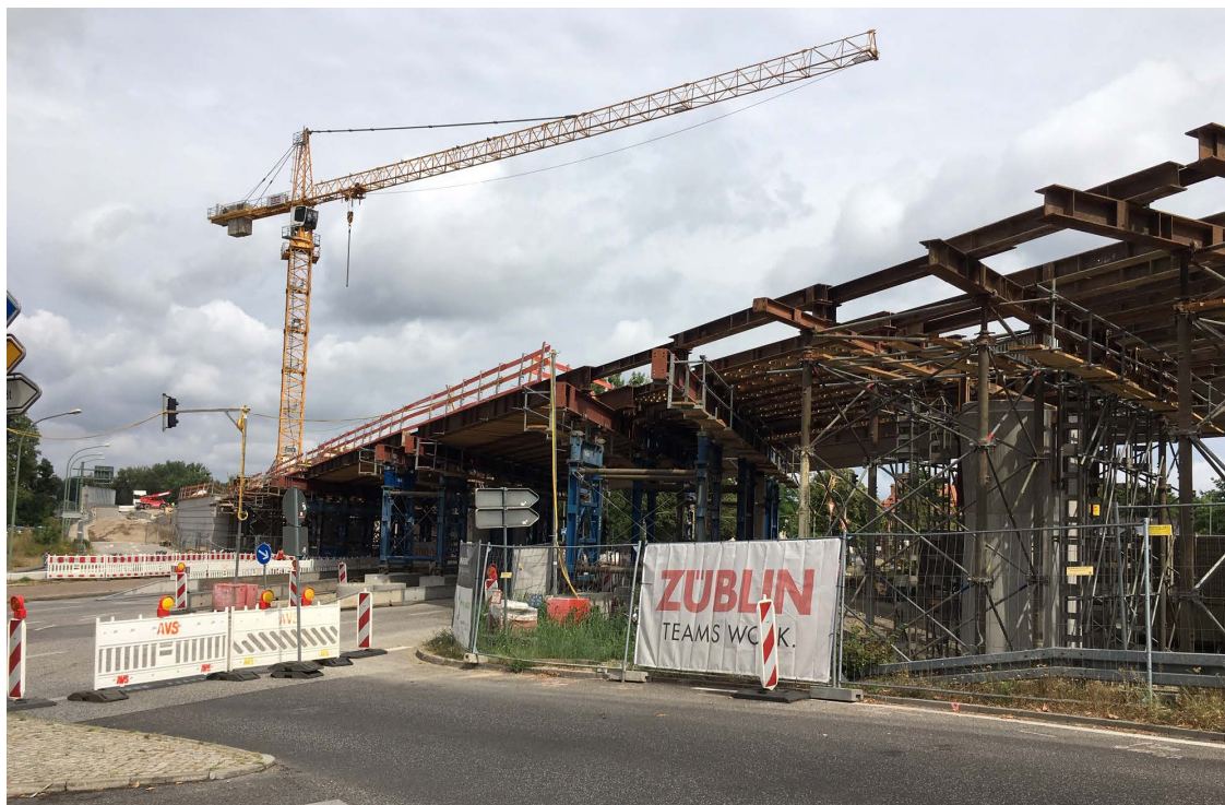
Abb. 3: L40 Hochstraßenbrücke im Bau, Foto: LS
