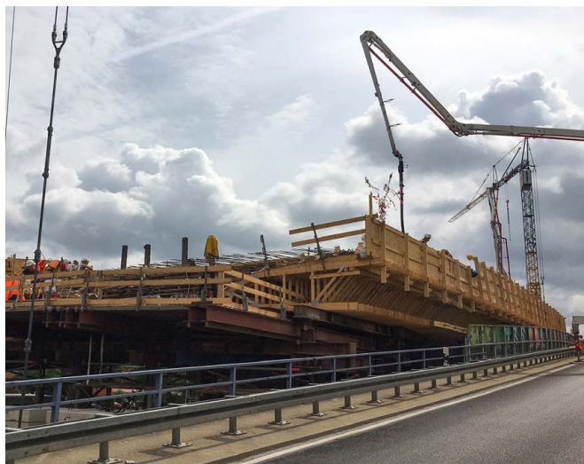
Abb. 4: L40 Hochstraßenrücke im Bau, Foto: LS
