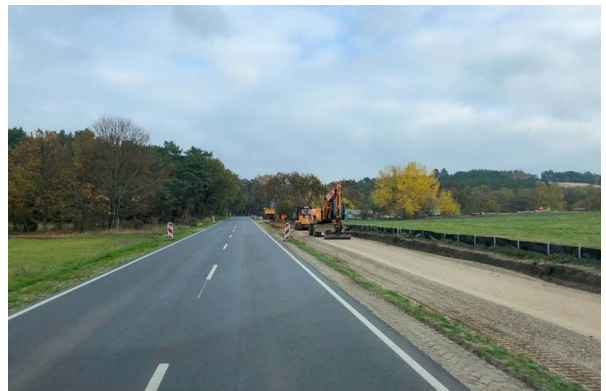
Abb. 8: Radwegebau an der L 77 Langerwisch - Saarmund, Foto: LS
