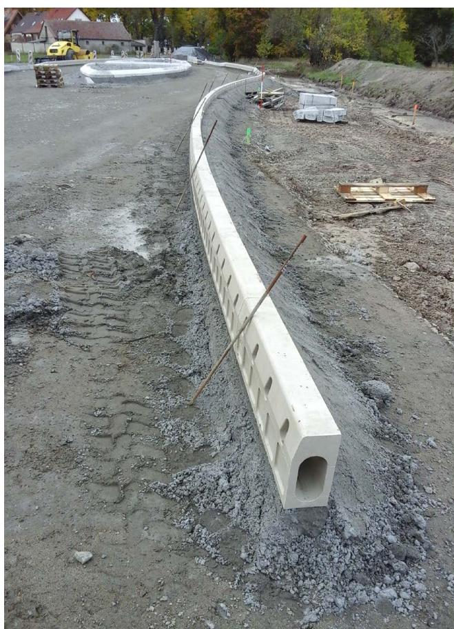
Abb. 2: Bau des Radweges an der L 77 von Saarmund nach Philippsthal, Foto: LS
