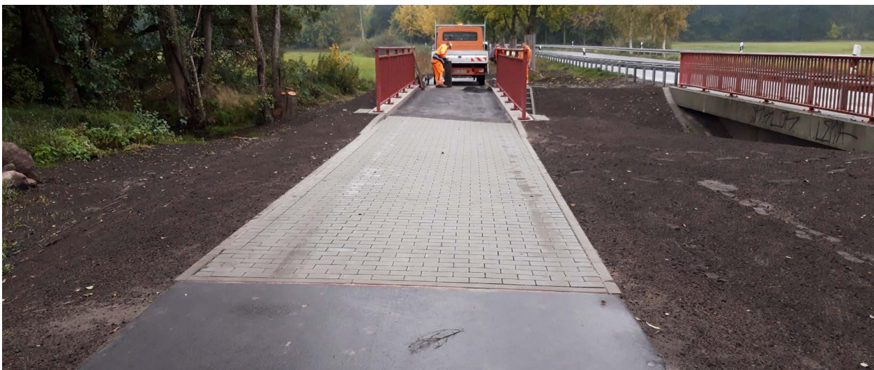
Abb. 28: Radwegebau an B 273 Wandlitz–Wensickendorf, Foto: LS
