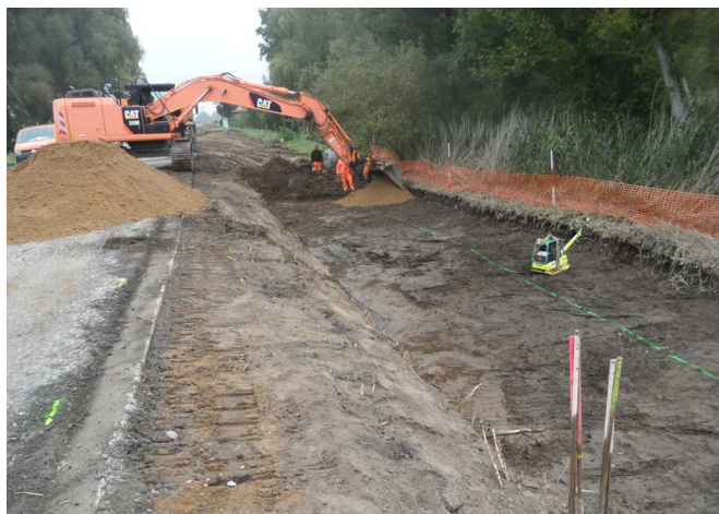
Abb. 16: Einbau von Füllboden für die 1. Lage Fange-Damm, Foto: LS
