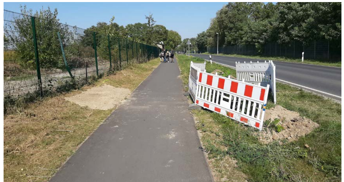
Abb. 30: Radwegneubau an der L 23 Hennickendorf–Herzfelde, Foto: LS
