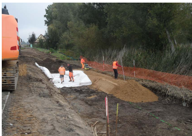
Abb. 17: Verlegung von Geotextil, Foto: LS
