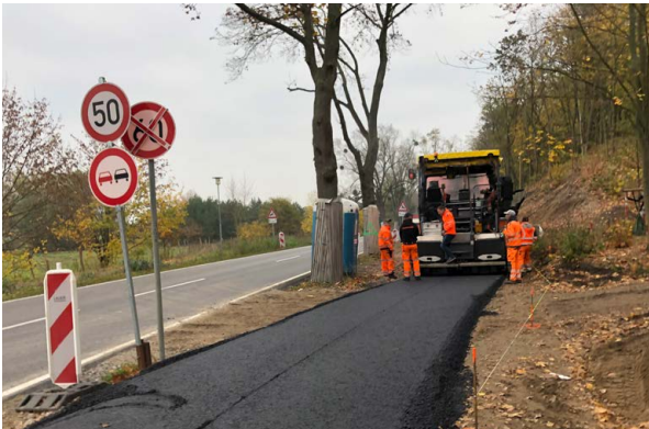
Abb. 7: Radwegebau an der L 77 Langerwisch - Saarmund, Foto: LS
