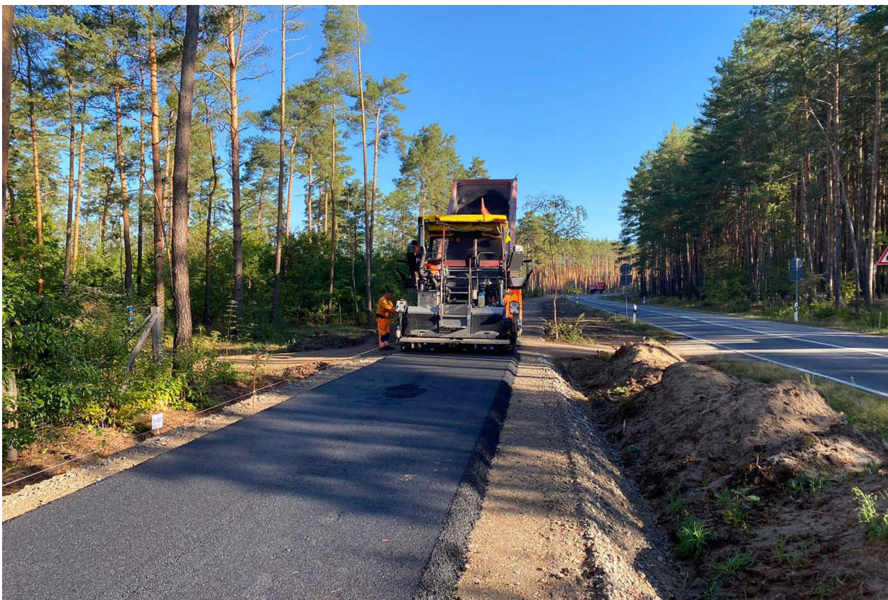
Abb. 12: Radwegebau an der L 90 Klaistow - Glindow, Foto: LS
