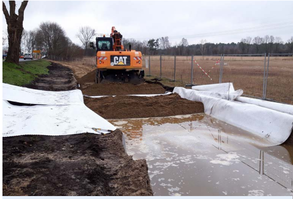
Abb. 25: Radwegebau an B 273 Wandlitz–Wensickendorf, Foto: LS
