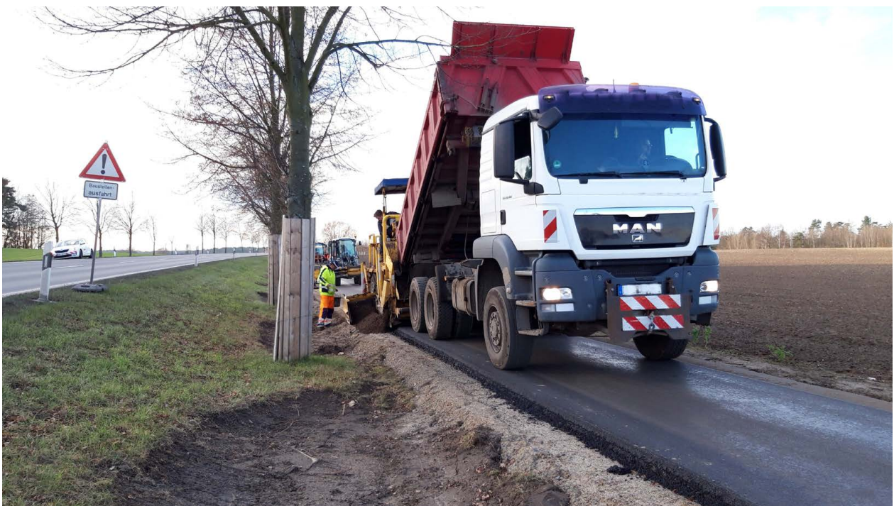
Abb. 23: Radwegebau an B 273 Wandlitz–Wensickendorf, Foto: LS
