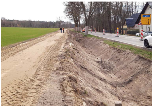
Abb. 26: Radwegebau an B 273 Wandlitz–Wensickendorf, Foto: LS
