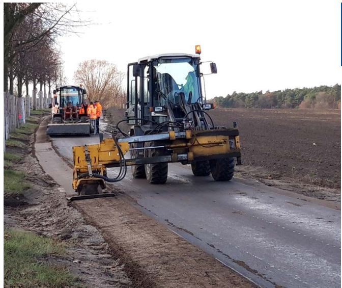
Abb. 22: Radwegebau an B 273 Wandlitz–Wensickendorf, Foto: LS
