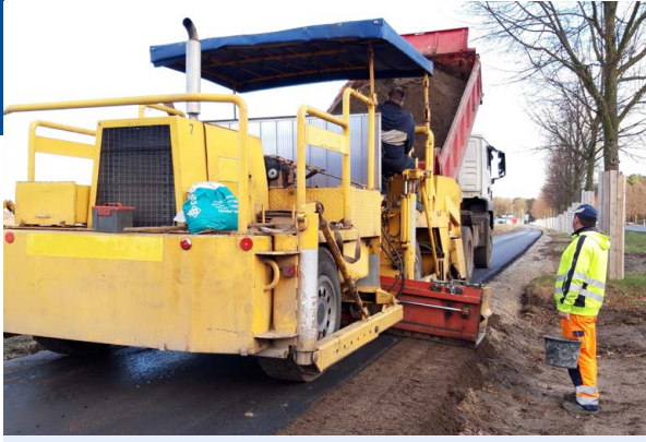
Abb. 24: Radwegebau an B 273 Wandlitz–Wensickendorf, Foto: LS
