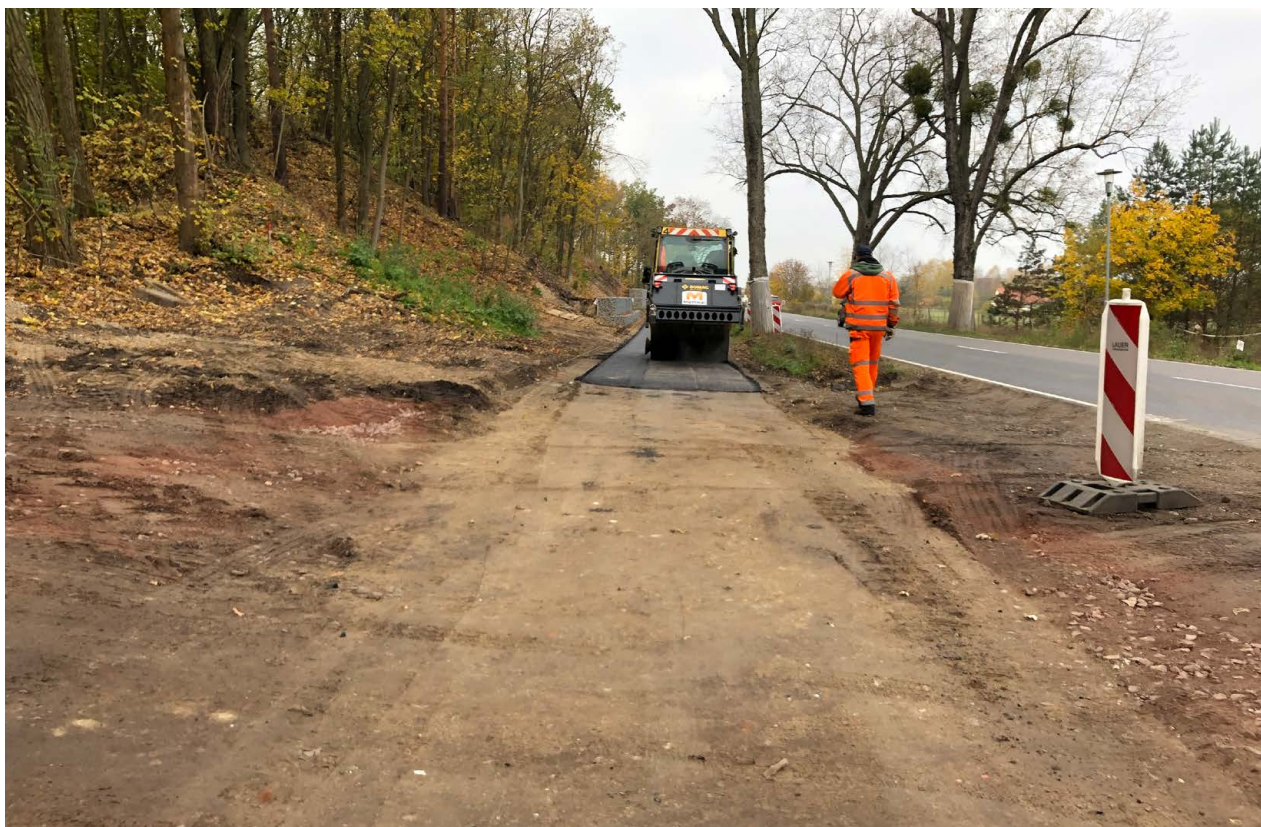
Abb. 4: Radwegbau an der L 77 Langerwisch - Saarmund, Foto: LS
