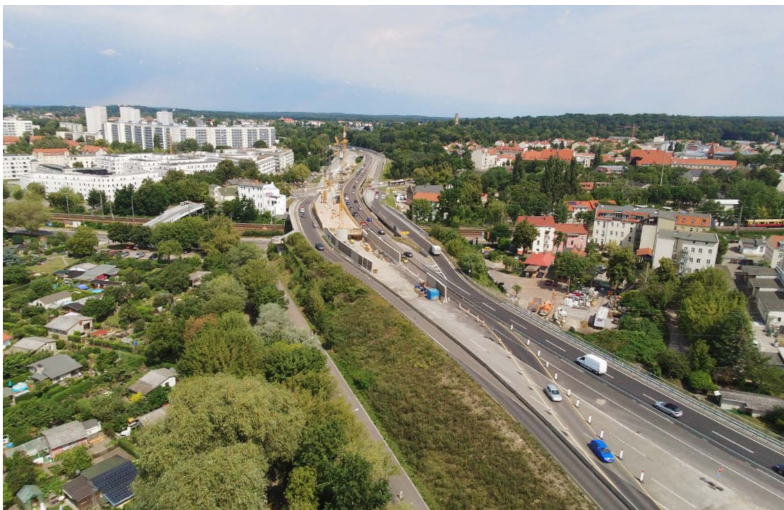
Abb. 34: Brückenneubau an der Nuthestraße in Potsdam, Baustellenüberblick mit Verkehrsführung, Foto: LS
