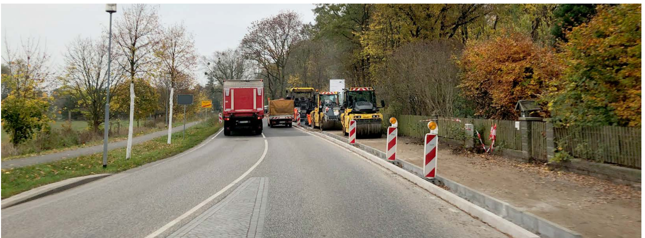
Abb. 9: Radwegebau an der L 77 Langerwisch - Saarmund, Foto: LS
