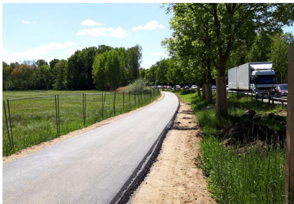
Abb. 27: Radwegebau an B 273 Wandlitz–Wensickendorf, Foto: LS
