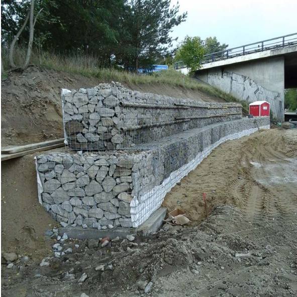
Abb. 5: Bau einer Gabionenwand, Foto: LS
