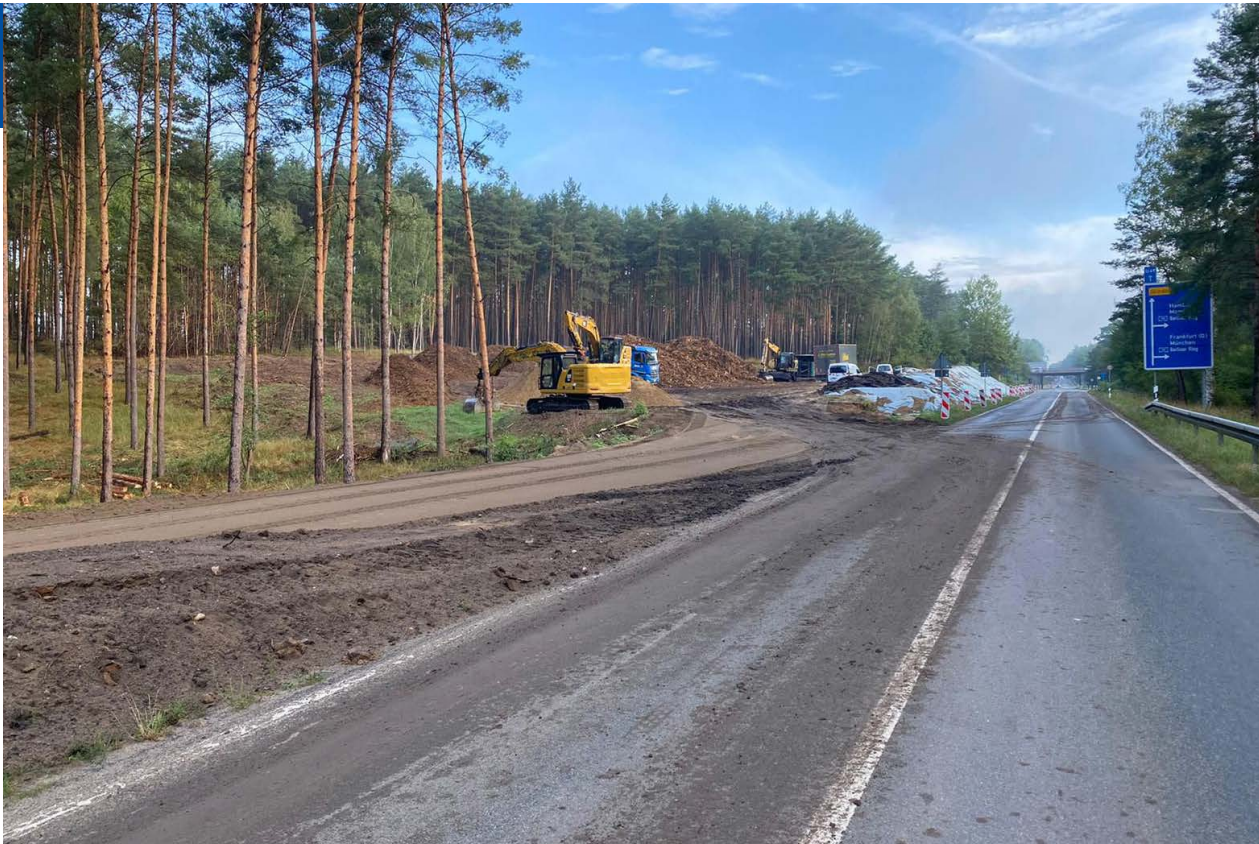
Abb. 13: Radwegbau an der L 90 Klaistow - Glindow, Foto: LS
