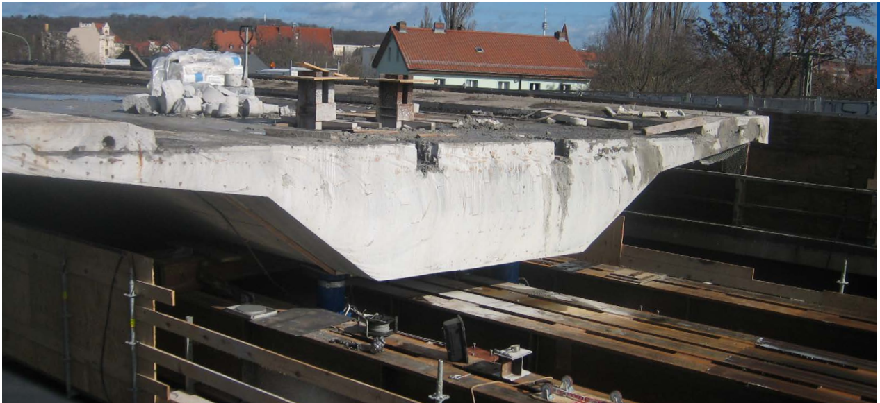
Abb. 35: Alter Überbau wird über die Verschubbahn herausgezogen, Foto: LS
