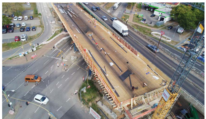
Abb. 37: Einbau der Spannglieder über Friedrich-List-Straße, Foto: LS
