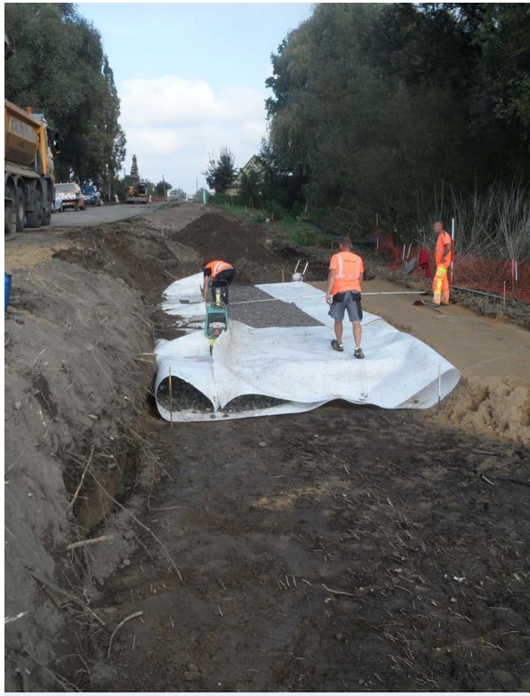
Abb. 20: Umschlagen von Geotextil, Foto: LS
