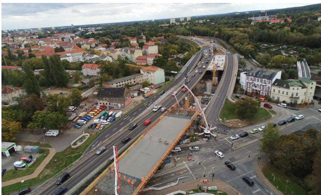
Abb. 39: Einbau der SGL über Friedrich-List-Straße, Foto: LS
