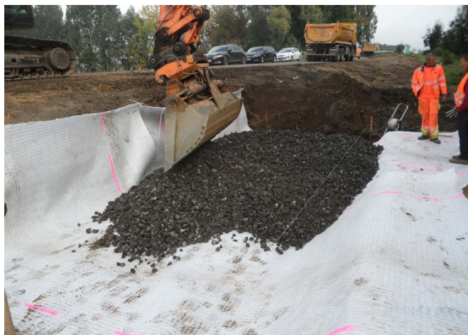
Abb. 18: Einbau 1. Lage Schaumglasschotter, Foto: LS
