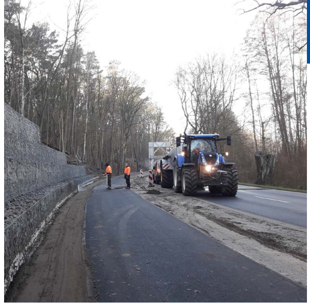
Abb. 6: Bau einer Gabionenwand, Foto: LS
