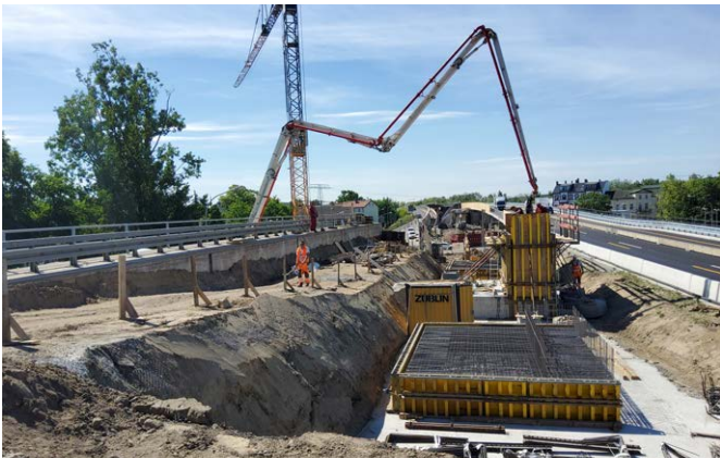
Abb. 18: Stützwand zwischen 1. und 2. Bauabschnitt, Foto: LS / KREBS+KIEFER Ingenieure GmbH
