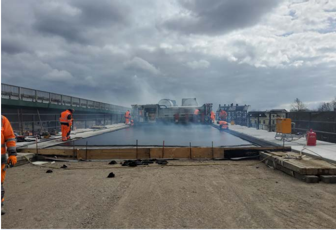
Abb. 16: Einbau Gussasphalt Hochstraßenbrücke 1. Bauabschnitt, Foto: LS / KREBS+KIEFER Ingenieure GmbH
