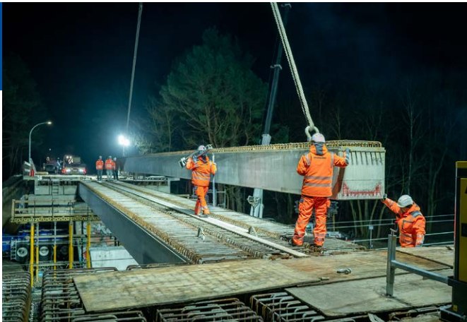
Abb. 24: L 171 Brücke Hohen Neuendorf Neubau, Foto: LS / drohne-berlin.com
