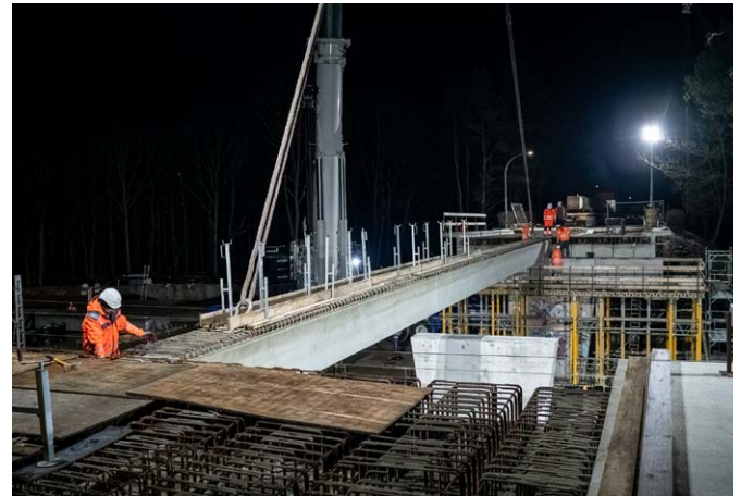
Abb. 25: L 171 Brücke Hohen Neuendorf Neubau, Foto: LS / drohne-berlin.com
