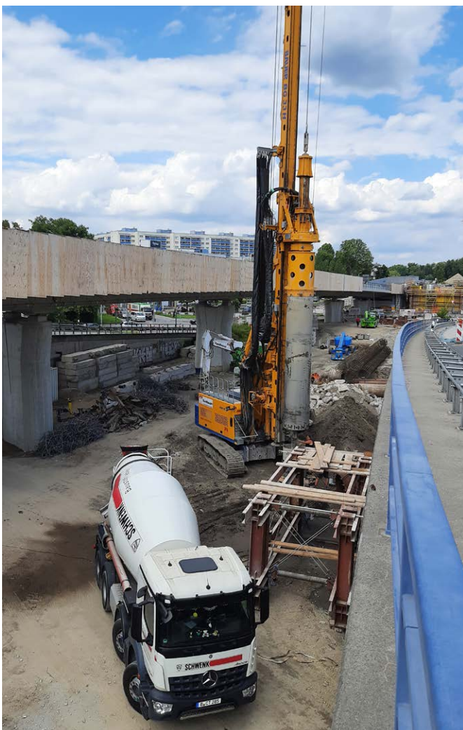
Abb. 21: Großbohrgerät im 2. Bauabschnitt im Einsatz; Foto: LS
