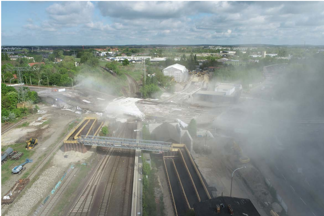
Abb. 6: Sprengung der Brücke am Altstädtischen Bahnhof, Foto: LS
