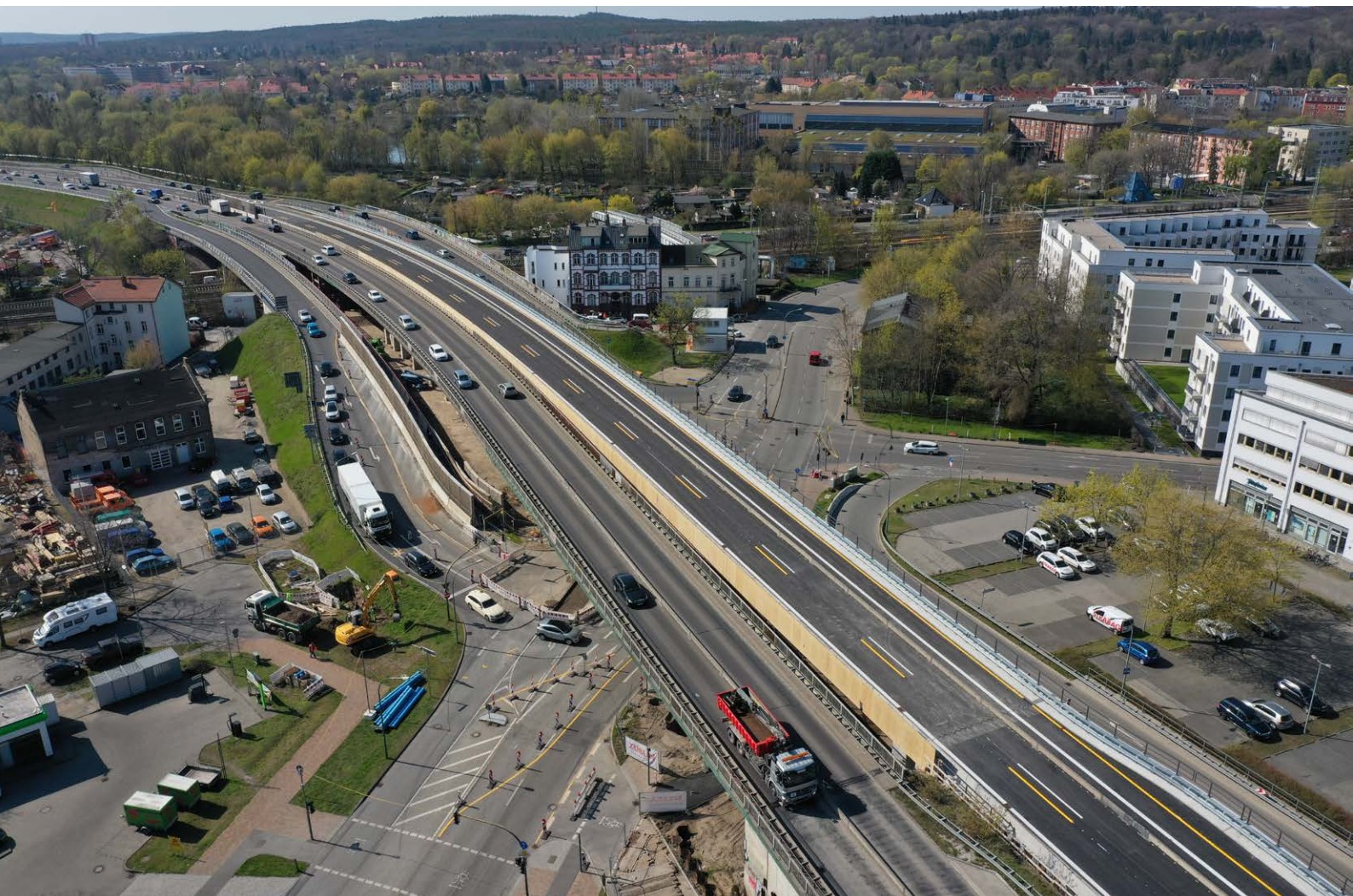
Abb. 15: Luftbild Hochstraßenbrücke L 40, Foto: LS
