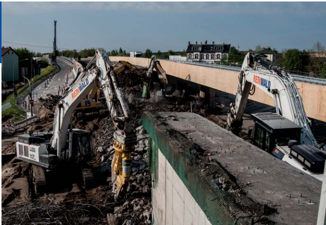
Abb. 20: Abbruch Hochstraßenbrücke 2. Bauabschnitt, Foto: LS / KREBS+KIEFER Ingenieure GmbH
