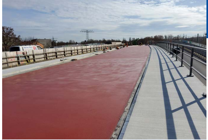
Abb. 17: Abdichtung Hochstraßenbrücke 1. Bauabschnitt, Foto: LS / KREBS+KIEFER Ingenieure GmbH
