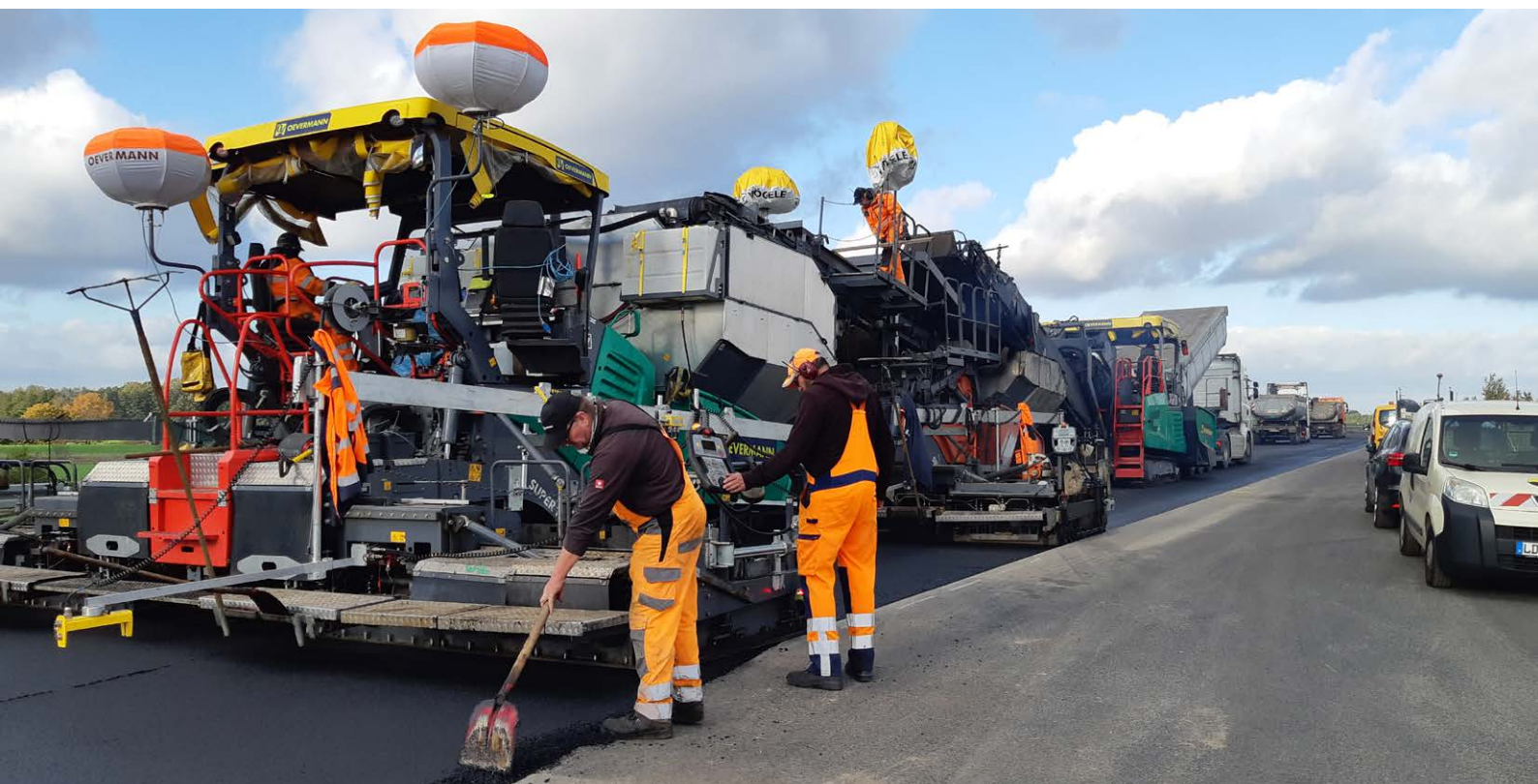
Abb. 30: B 101, Ortsumfahrung Liebenwerda, Baujahr 2021, Foto: LS
