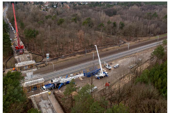
Abb. 27: L 171 Brücke Hohen Neuendorf Abriss, Foto: LS / drohne-berlin.com
