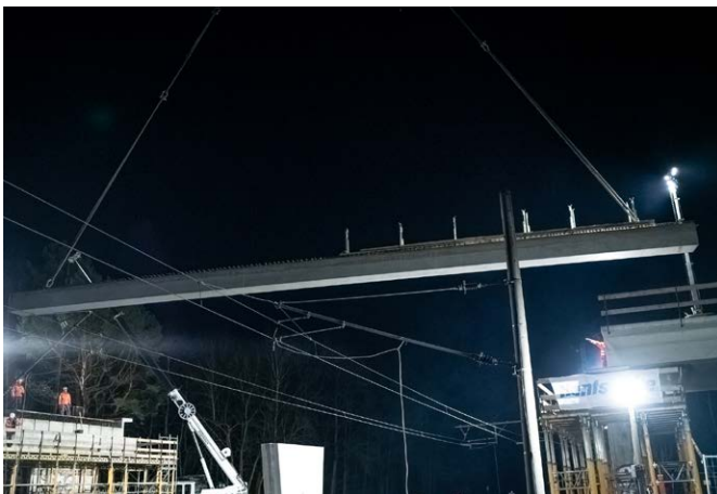
Abb. 26: L 171 Brücke Hohen Neuendorf Neubau, Foto: LS / drohne-berlin.com
