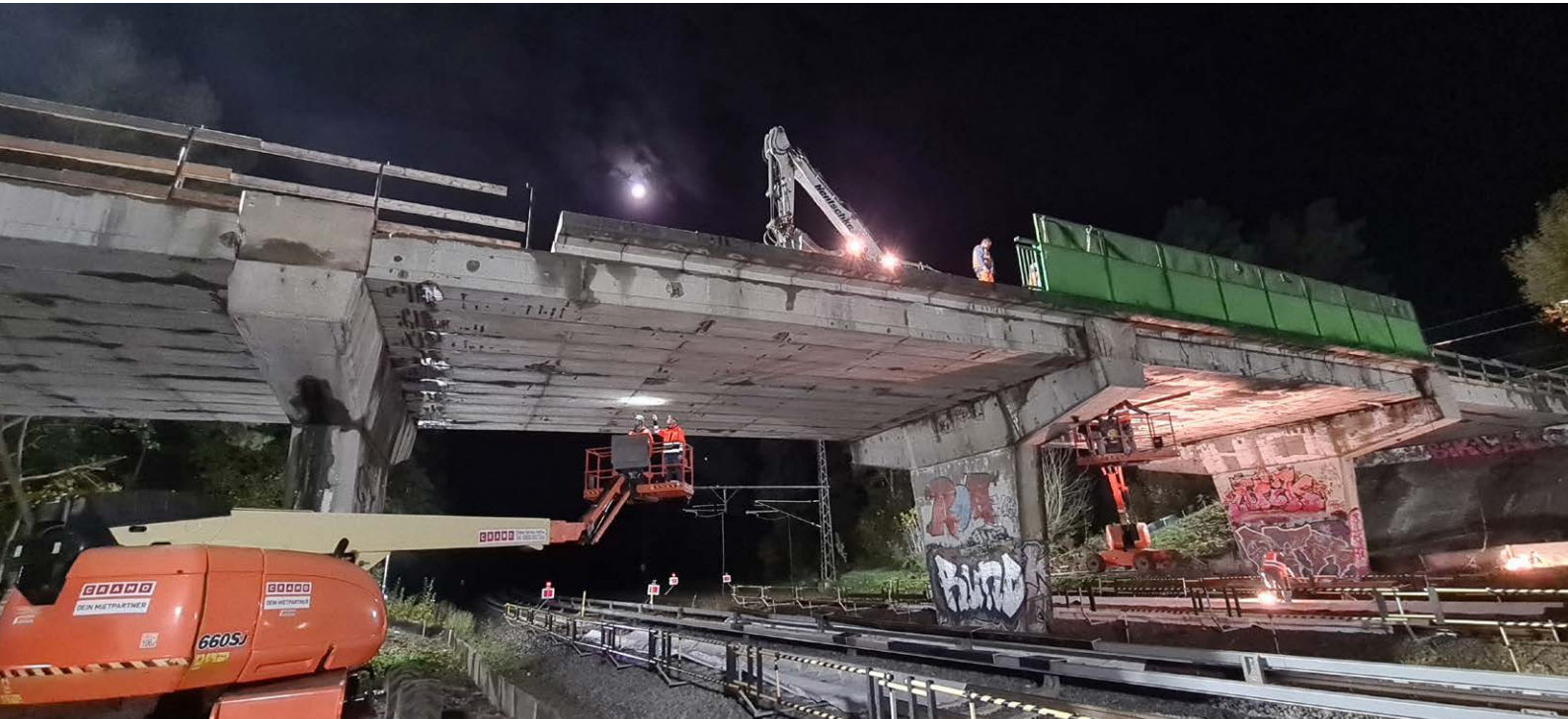
Abb. 23: L 171 Brücke Hohen Neuendorf Abriss, Foto: LS / drohne-berlin.com
