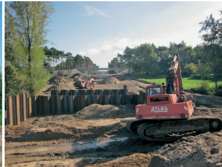
Errichtung der Grabenbrücke über den Dahnsdorfer Bach
