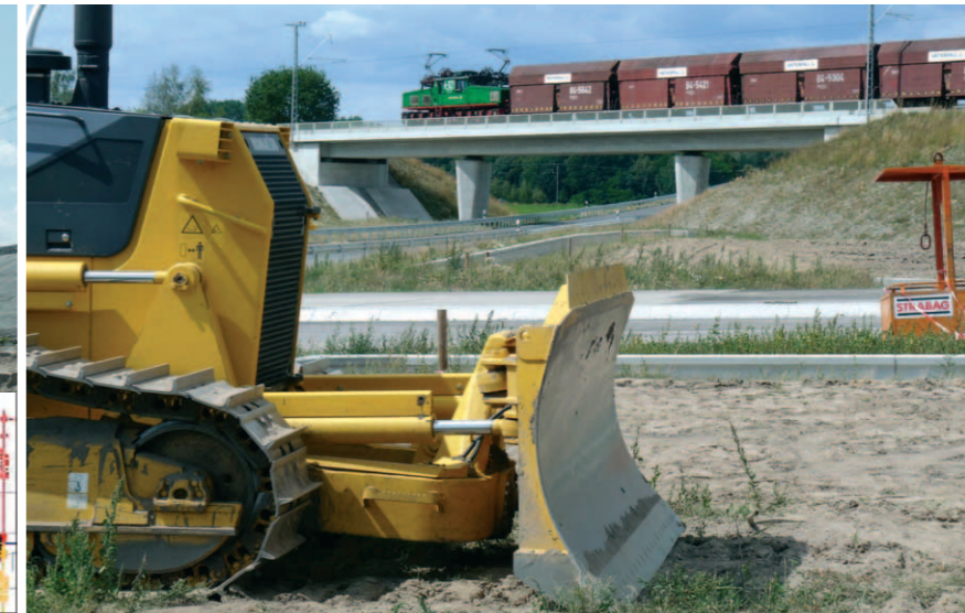
Nach Beendigung der Brückenbauarbeiten wurde das Gleis auf die ursprüngliche Trasse zurückverlegt.
