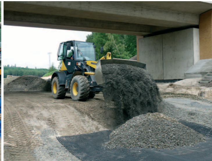
Verankerung durch Vorkopfschüttung
