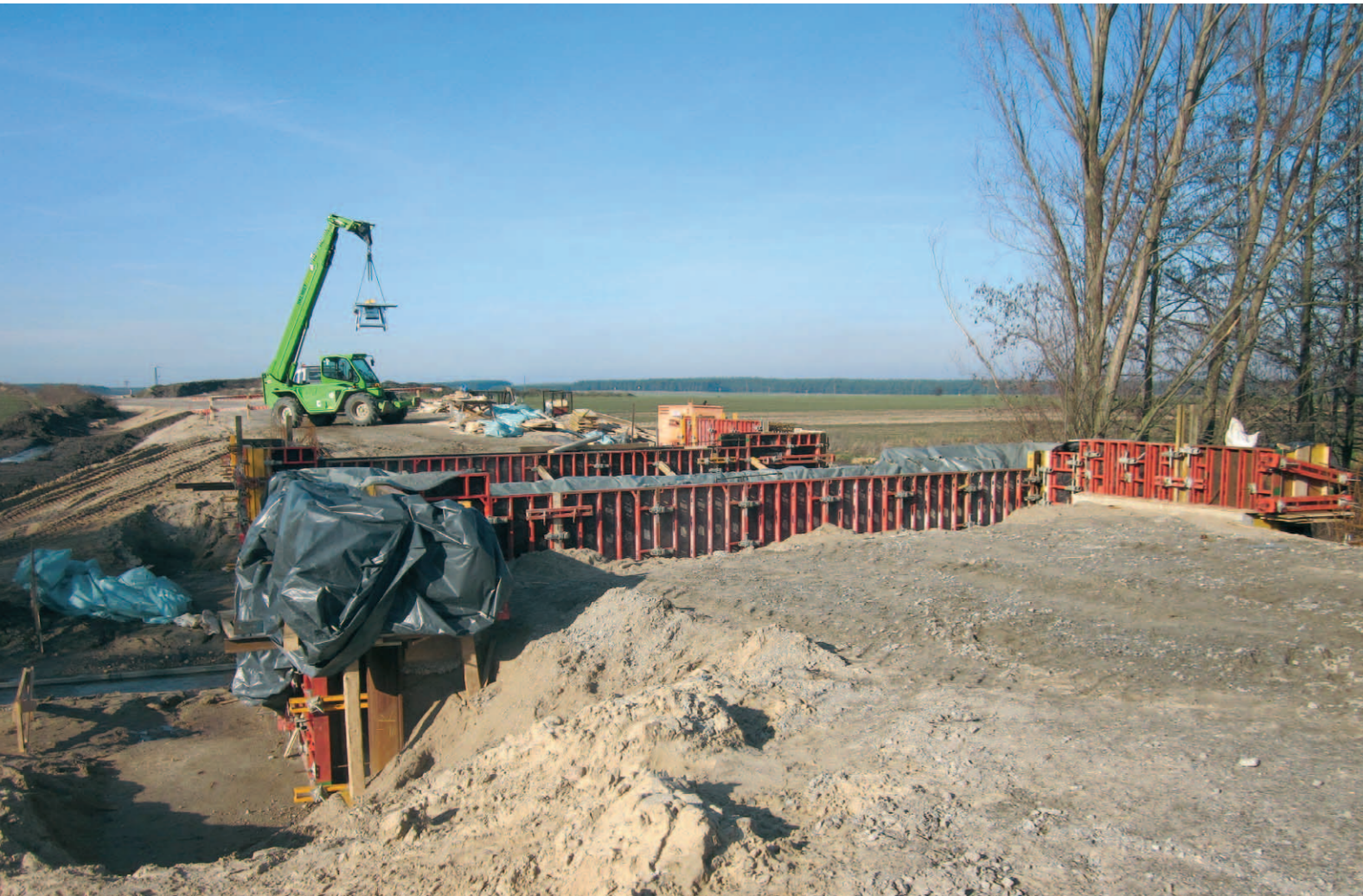
Für den Neubau der Grabenbrücke werden die Widerlager geschalt.
