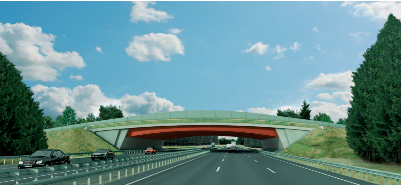
Visualisierung einer Grünbrücke in Verbundbauweise
