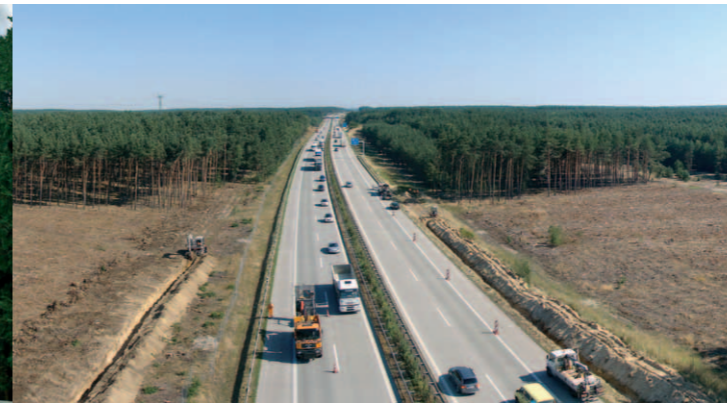
Eingriffsfläche an der A 13 vor Baubeginn
