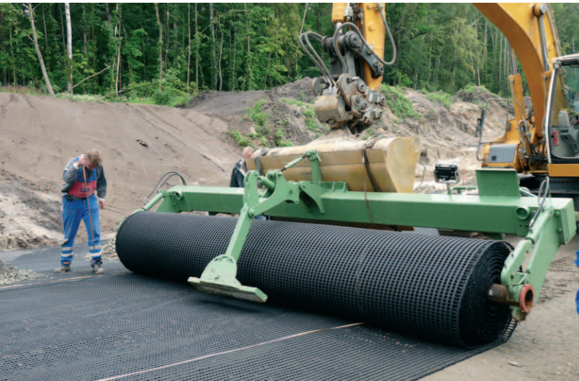
Verlegung des Geogitters
