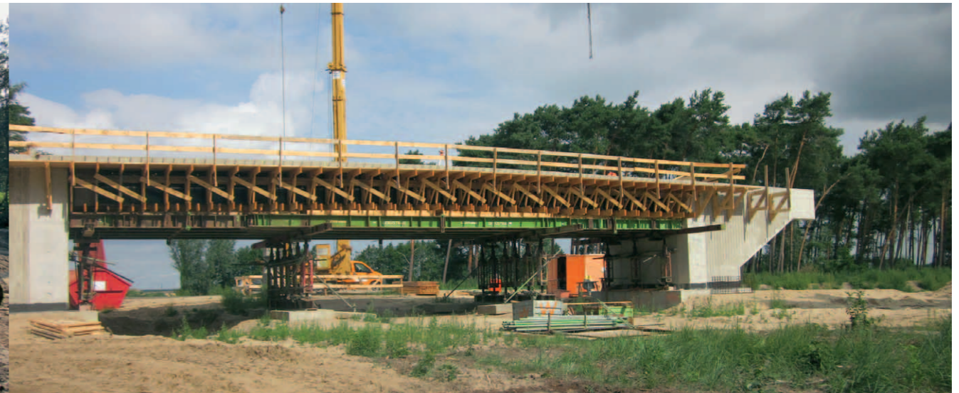
Das Überführungsbauwerk im Zuge der Waldstraße erhält seinen Überbau.
