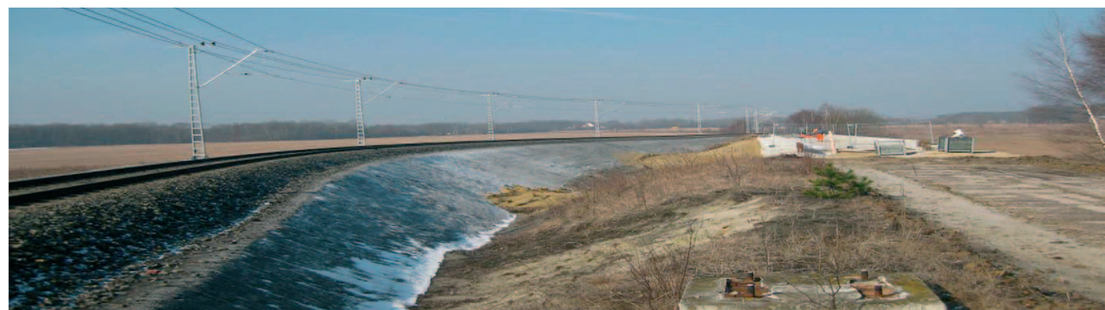
Behelfsdamm für die Werkbahn zum Kraftwerk Schwarze Pumpe
