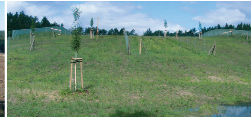
Bepflanzte Rampe an der A9 nach Bauende
