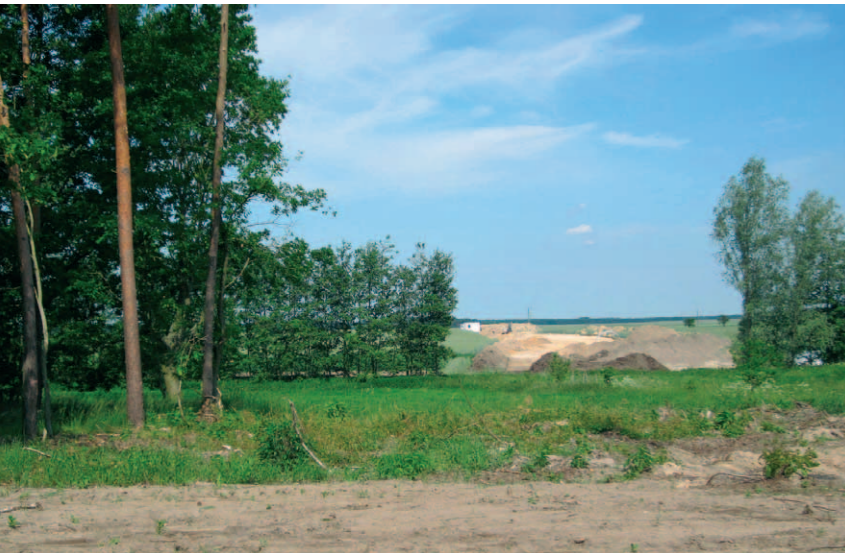
Trasse der Ortsumgehung zu Baubeginn
