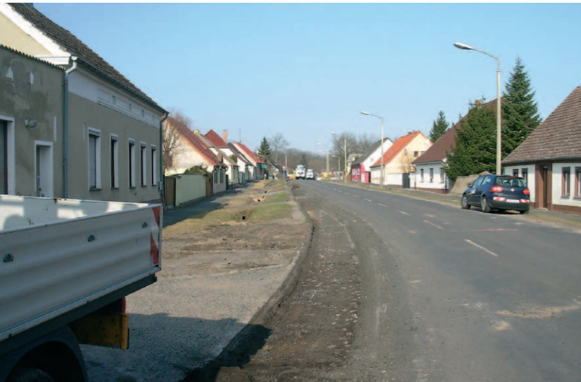
Blick auf die Hauptstraße zu Beginn der Baumaßnahme (März 2011)
