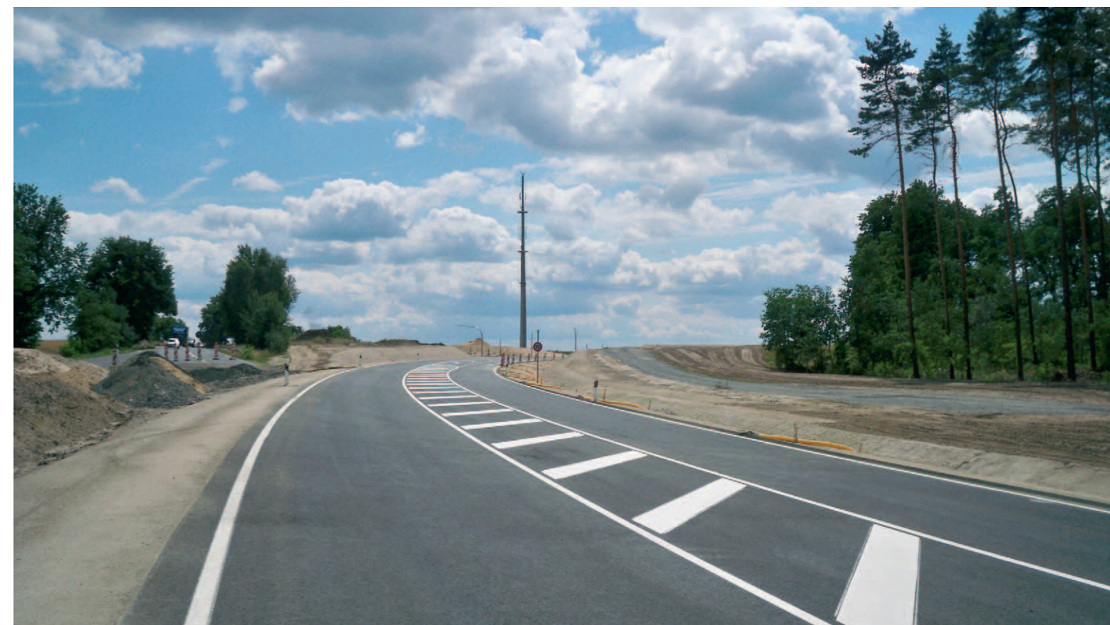
Ortsumgehung Spremberg/Schwarze Pumpe
