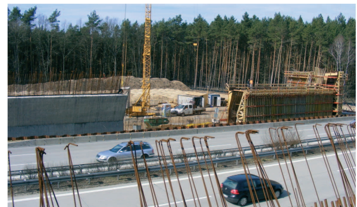
Segmentweise Herstellung der Rahmenwände
