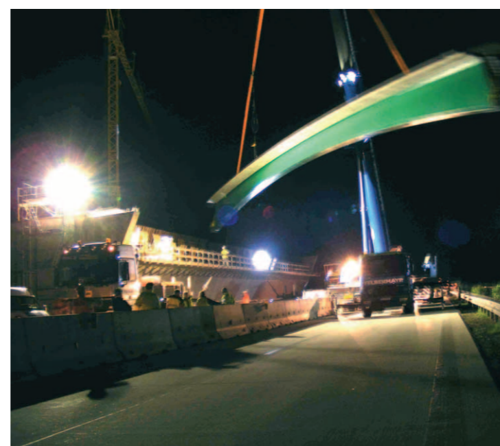
Montage der Fertigteile in der Nacht
