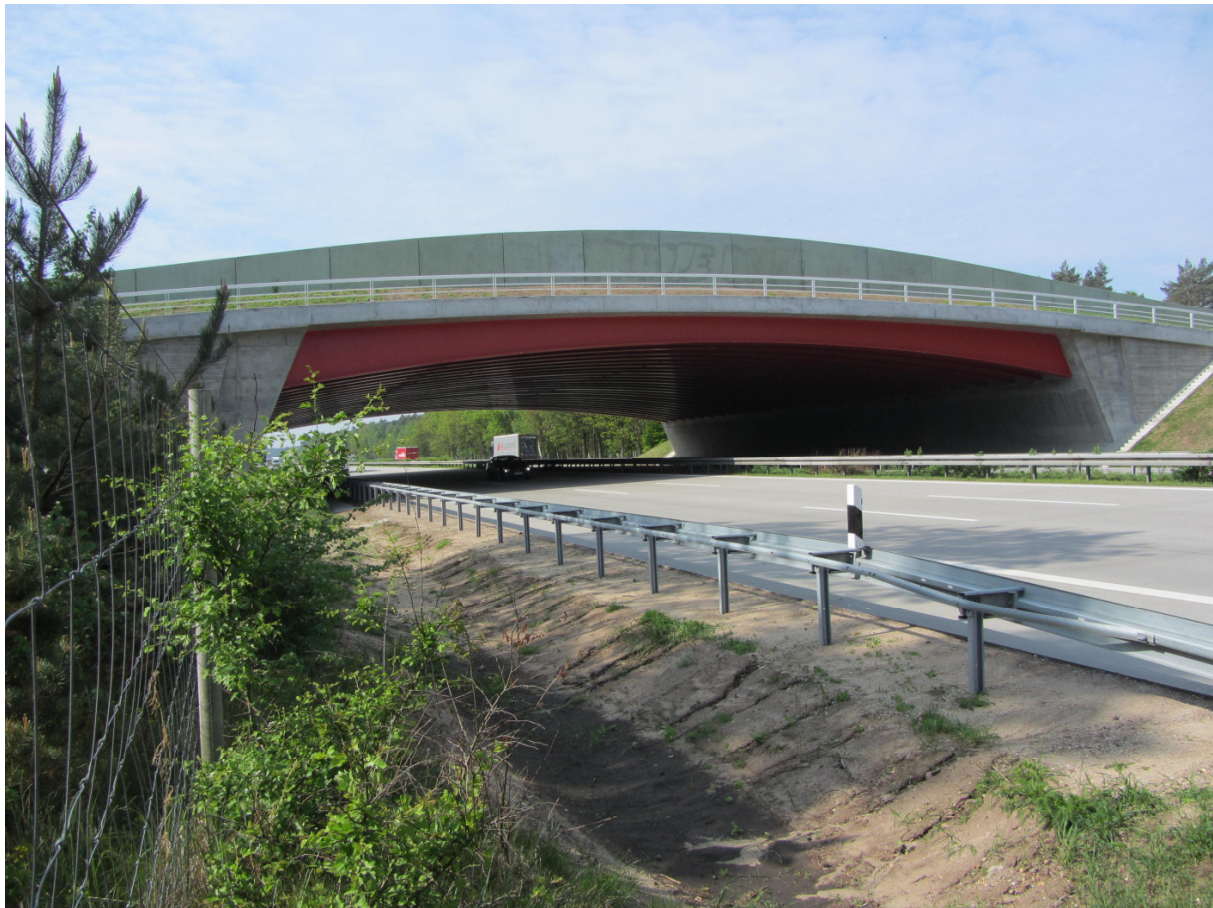
Abb. 1: Grünbrücke über die BAB 9 bei Niemegk
