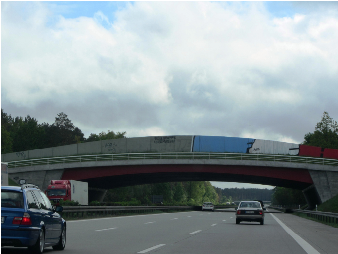
Abb. 12: „Bemalte“ nördliche Sichtschutzwand der Grünbrücke über die BAB 9
