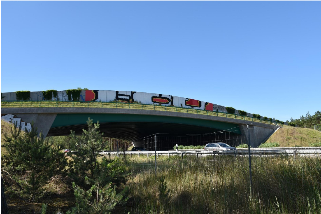
Abb. 23: Grünbrücke über die BAB 13 bei Teupitz
