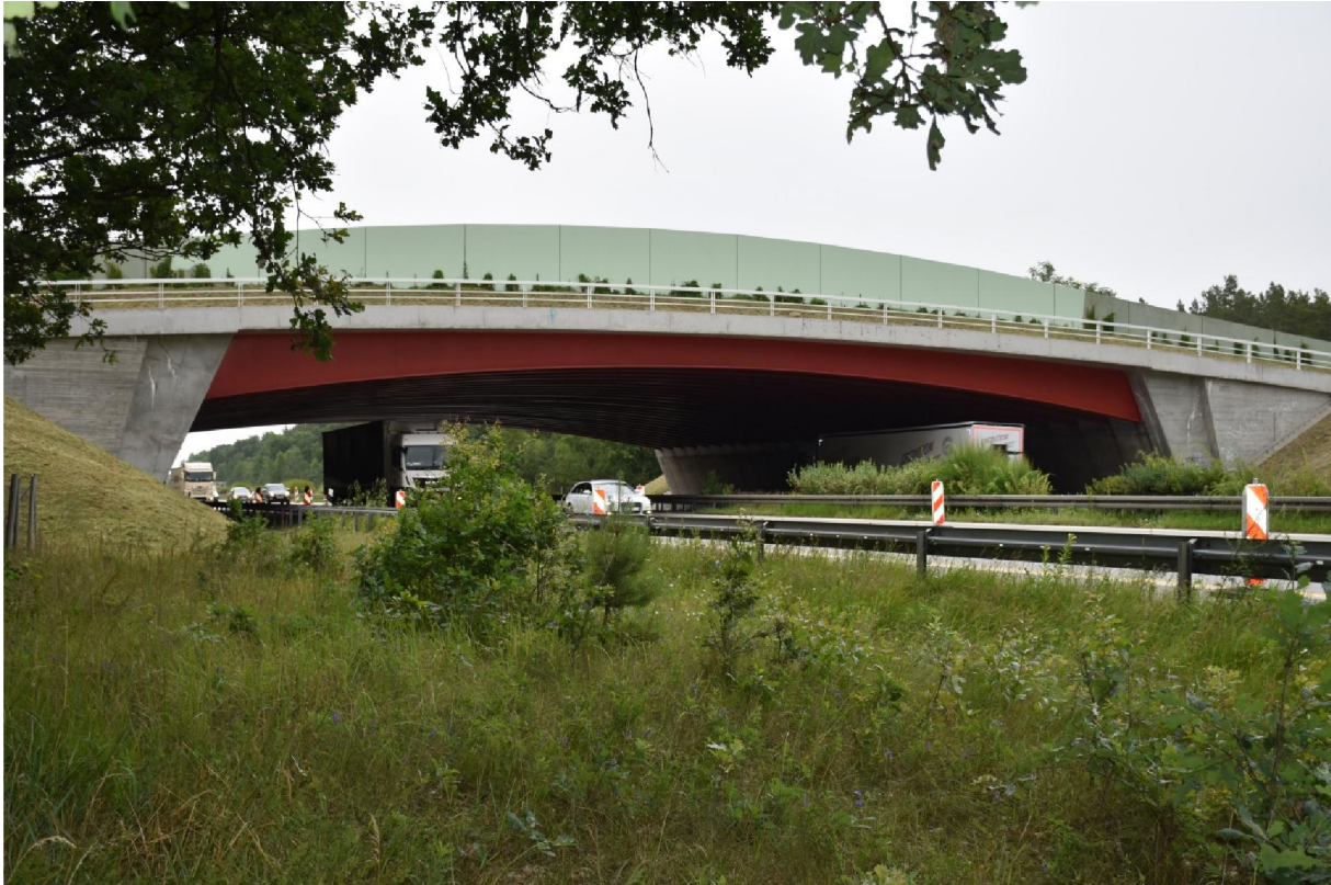
Abb. 1: Grünbrücke über die BAB 9 bei Niemegk
