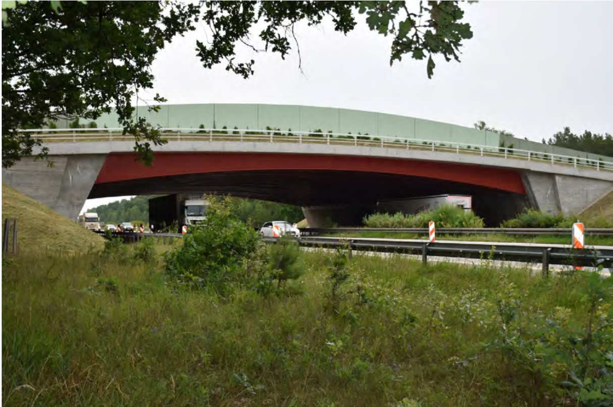
Abb. 2: Grünbrücke über die BAB 9 bei Niemegk
