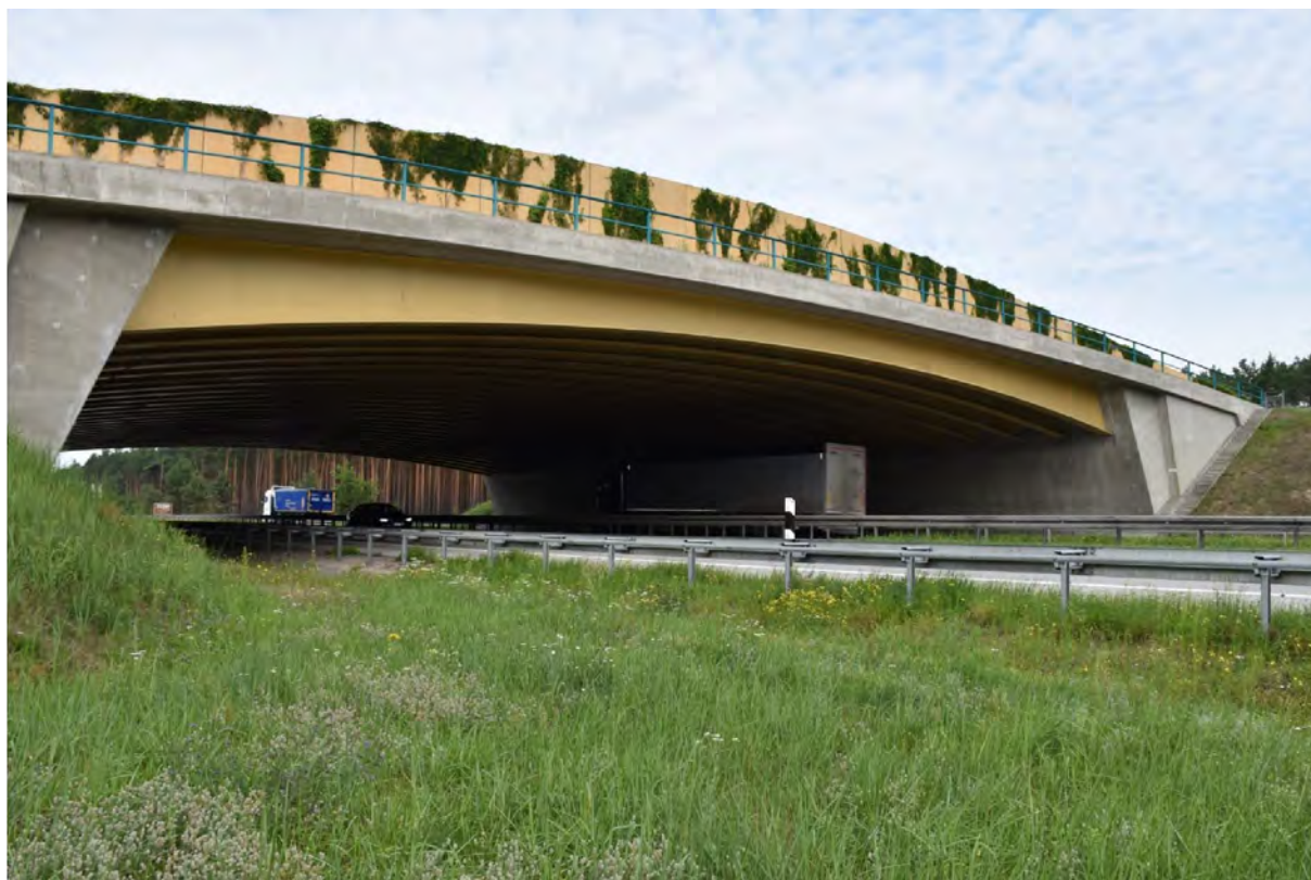
Abb. 94: Grünbrücke über die BAB 12 bei Kersdorf
