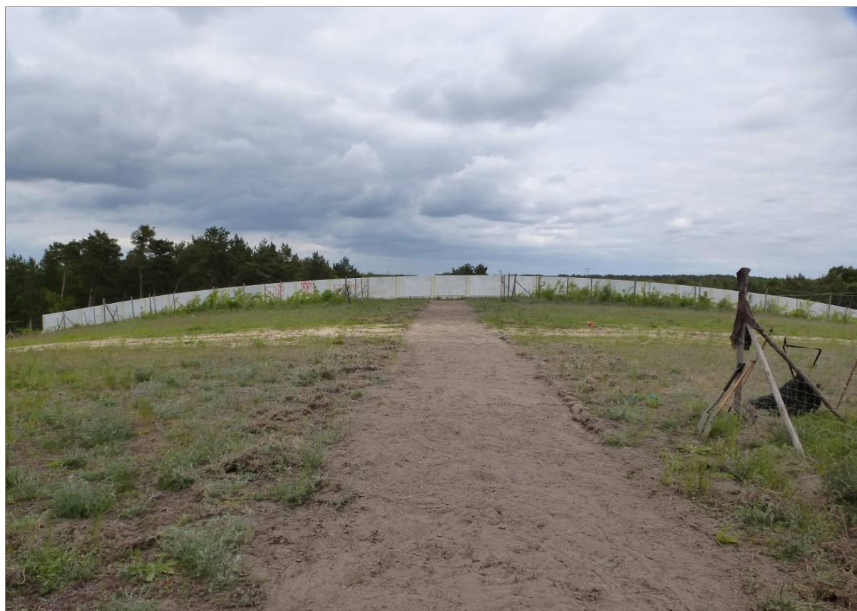
Abbildung 2: 2015 hergestellter Kontrollstreifen mittig der Grünbrücke
