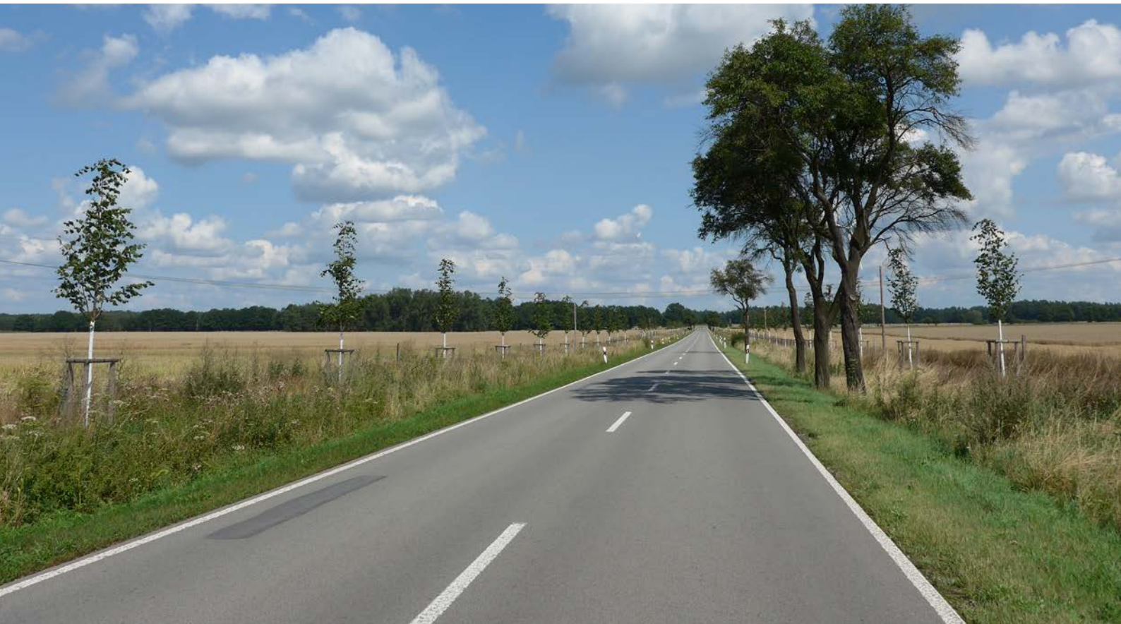
Ersatzmaßnahme an der L13 – Hinterpflanzen der Allee
