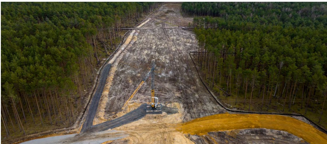
Abb. 12: Baulos 4 (Blick vom Baulos 2 in Baulos 4 bzw. Richtung Autobahn), Foto: LS
