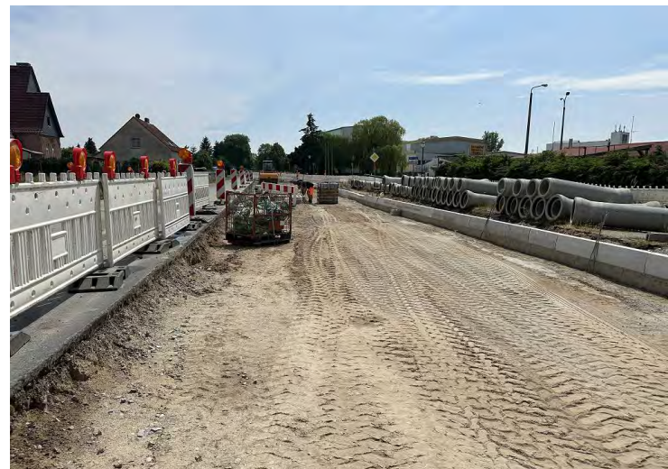
Abb. 15: L 13 Sanierung der Ortsdurchfahrt Karstädt und Postlin, Foto: LS
