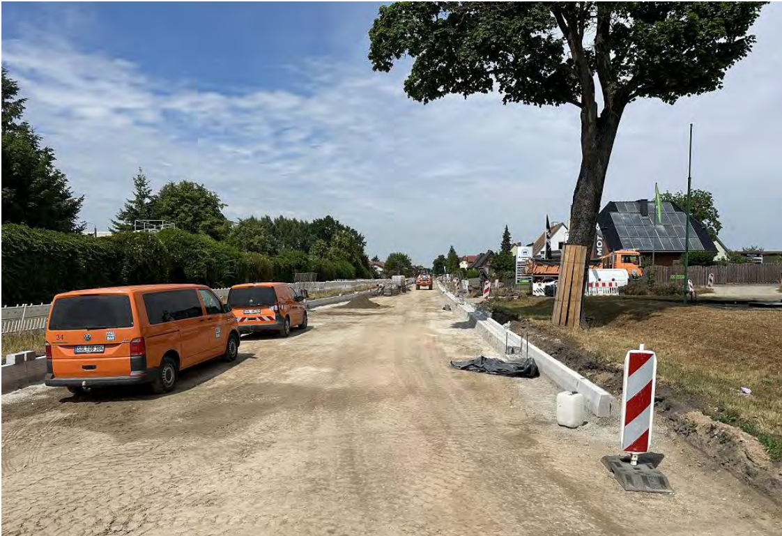
Abb. 16: Bauarbeiten auf der L 13 Karstädt und Postlin im Juni 2023, Foto: LS
