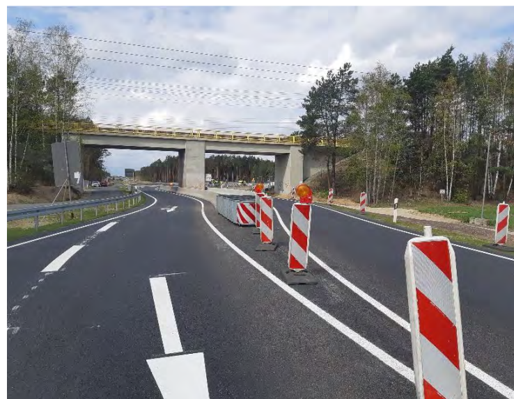
Abb. 6: B 97 Netzergänzung Kohlebahnbrücke, Foto: LS
