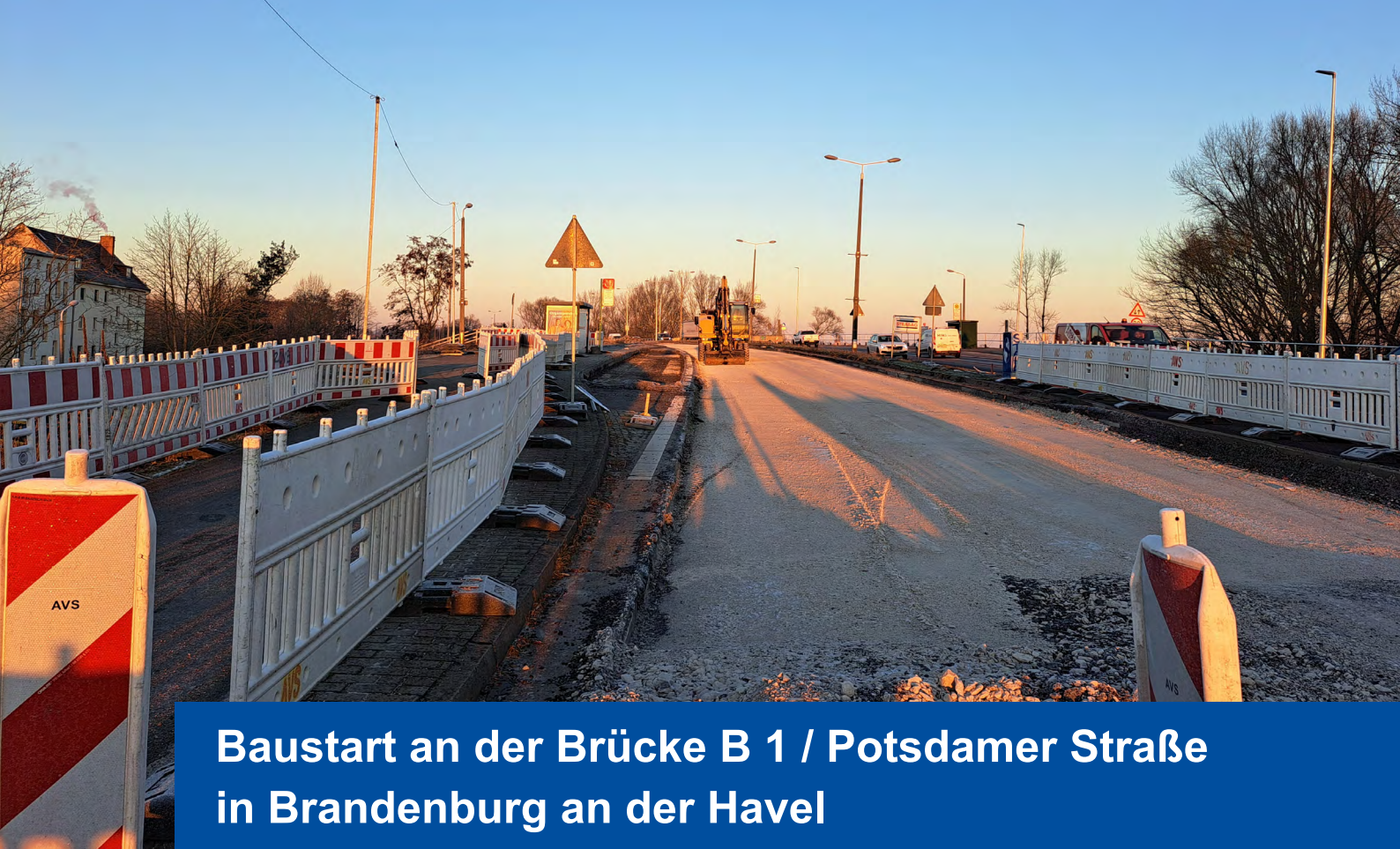
Abb. 4: B 1 Brücke Potsdamer Straße Schmerzke, Foto: LS
