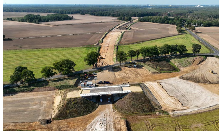
Abb. 11: Luftaufnahme Baulos 3 (Verlauf der B 168 Richtung Cottbus und Bauwerk über B 168 bei Kahren), Foto: LS
